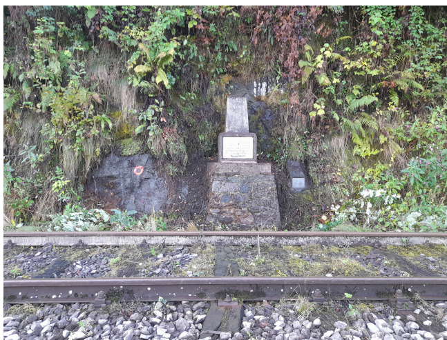
Slika 20: Primer enega najstarejših reperjev pri nas.
