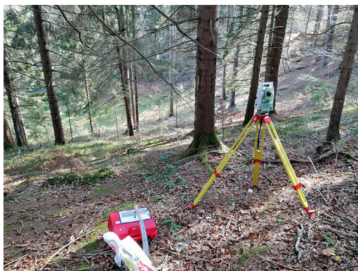
Slika 7: Izmera geodetskega poligona na gozdnem delu odseka na stojišču 103 (foto: Luka Pišljar).
