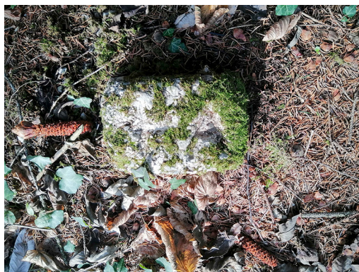
Slika 8: Betonsko bočno zavarovanje sektorskega mejnika 41 z oznako +A (foto: Luka Pišljar).
