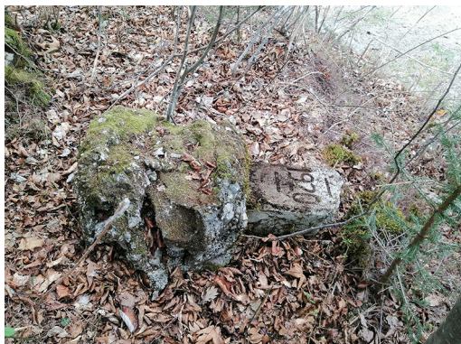
Slika 5: Izruvan manjkajoči mejnik 40/LIX (foto: Luka Pišljar).
