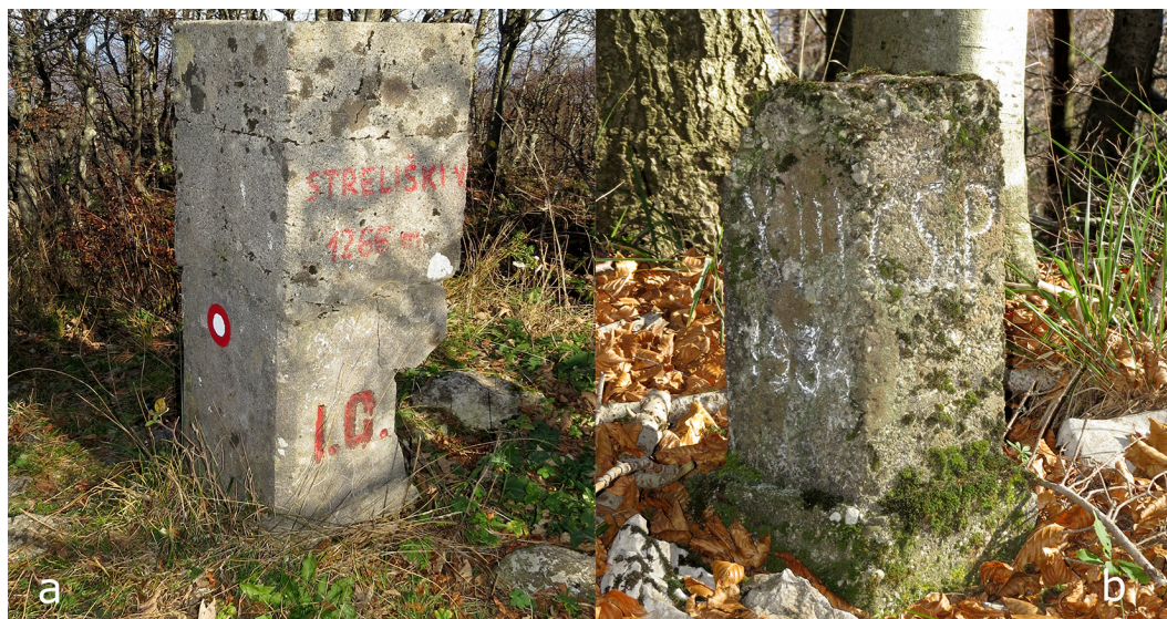
Slika 16: a) italijanski betonski trigonometrični steber višine 110 cm na Streliškem vrhu, b) manjši betonski stebriček višine 52 cm na Lipovem vrhu (foto: M. Triglav Čekada, 2024).
