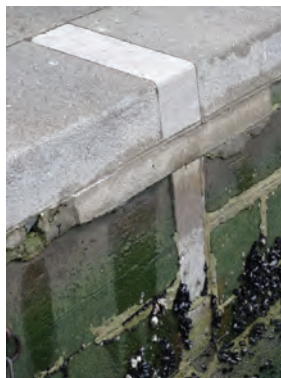
Slika 2: Obležje stare rešitve za opazovanje nihanja gladine morja v Trstu.
