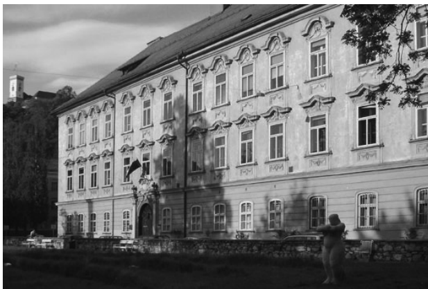
Stavba Arhiva republike Slovenije v Ljubljani, Zvezdarska ulica 1
