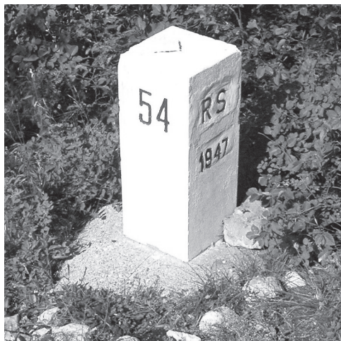
Slika 2: Glavni mejni znak: armiranobetonski blok dimenzij 28 x 28 x 75 cm (levo) in marmornata plošča dimenzij 28 x 28 cm (desno).
