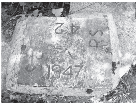
Slika 2: Glavni mejni znak: armiranobetonski blok dimenzij 28 x 28 x 75 cm (levo) in marmornata plošča dimenzij 28 x 28 cm (desno).
