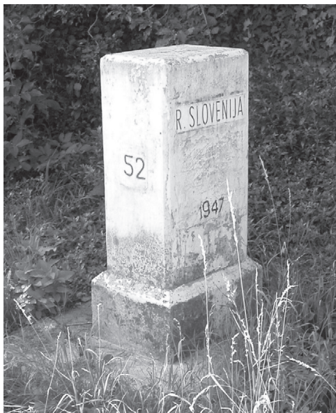
Slika 4: Specialni glavni mejni znak – armiranobetonski blok dimenzij 50 x 35 x 120 cm (levo) in pomožni mejni znak – marmornata plošča dimenzij 28 x 28 cm (desno).
