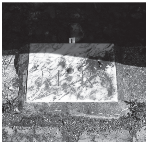
Slika 4: Specialni glavni mejni znak – armiranobetonski blok dimenzij 50 x 35 x 120 cm (levo) in pomožni mejni znak – marmornata plošča dimenzij 28 x 28 cm (desno).
