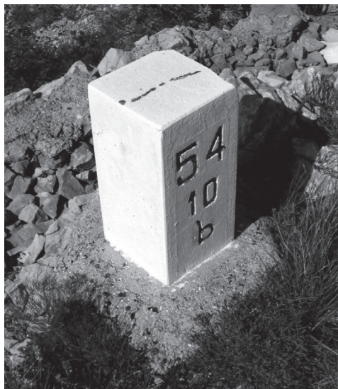
Slika 3: Vmesni mejni znak: armiranobetonski blok dimenzij 20 x 20 x 40 cm (levo) in marmornata plošča dimenzij 20 x 20 cm (desno).
