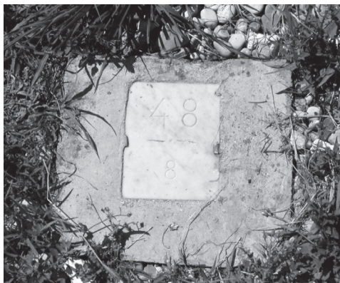
Slika 3: Vmesni mejni znak: armiranobetonski blok dimenzij 20 x 20 x 40 cm (levo) in marmornata plošča dimenzij 20 x 20 cm (desno).
