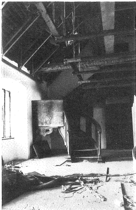
Slika 1: Obnova največjega prostora geodetske zbirke (osrednji prostor)
