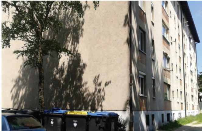
Slika 3: Obravnavana stavba; pogled na južno in vzhodno fasado.
