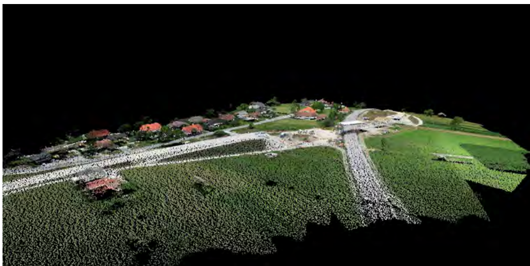
Slika 6: Oblak točk na gradbišču cestnega odseka, izdelan iz posnetkov, ki so bili zajeti s sistemom DŽGS Flyeye.
