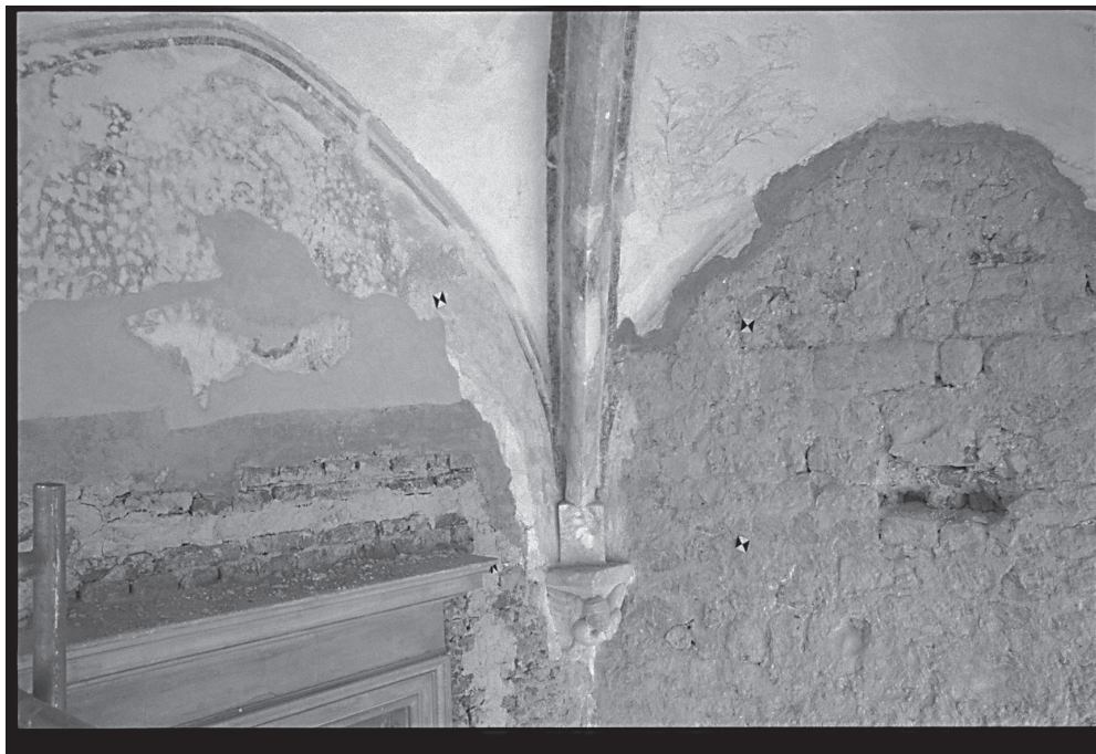
Slika 1: S fotografiranjem ostenja smo ohranili informacije, ki so pod ometi nedosegljive. Na sliki je posnetek stika dveh notranjih sten s stropom križnega hodnika in vsemi podrobnostmi "golega" zidu.
